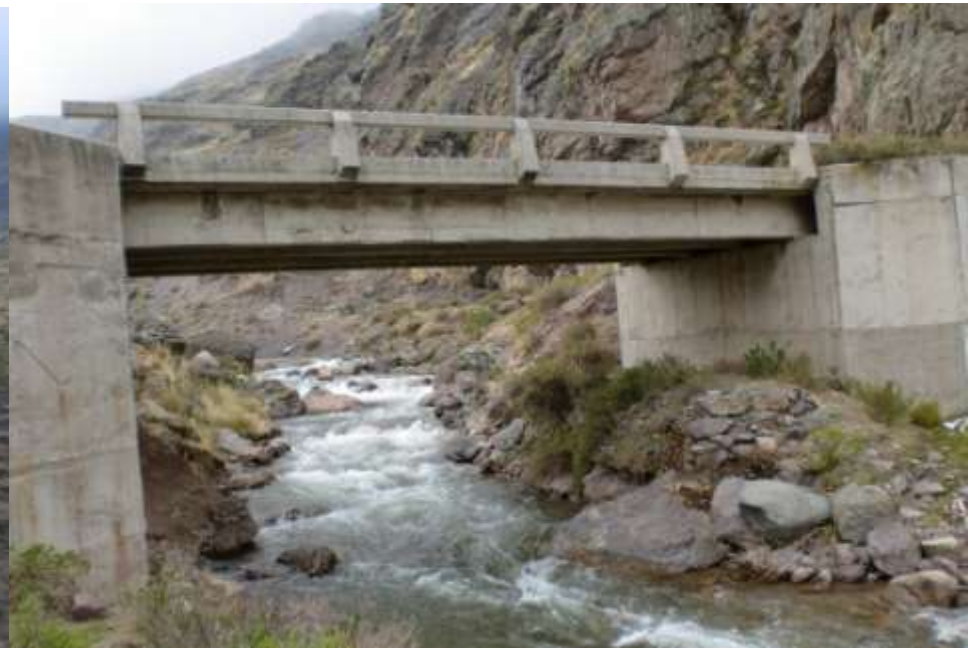
PUENTE construido por SEDAPAL, en 1999, con 12 m. de luz
