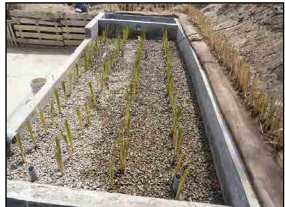
Abb. 45: Verschiedene Bauabschnitte einer Pflanzenkläranlage, Quelle: MITTERMAYER (Kein Datum)
