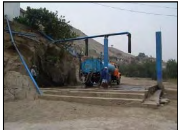
Abb. 30: An den offiziellen Zapfsäulen von SEDAPAL können die camiones cisternas ihr Wasser kaufen, Quelle: FOVIDA 2011.
