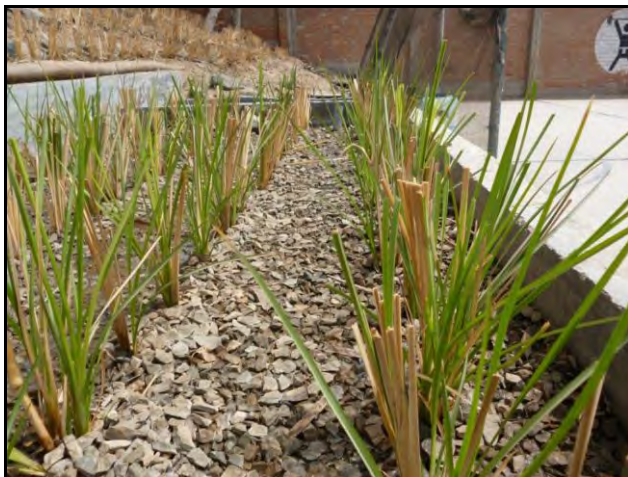
Abb: 43: Vetiver-Gras in einer Pflanzenkläranlage, Quelle: MITTERMAYER (Kein Datum)
