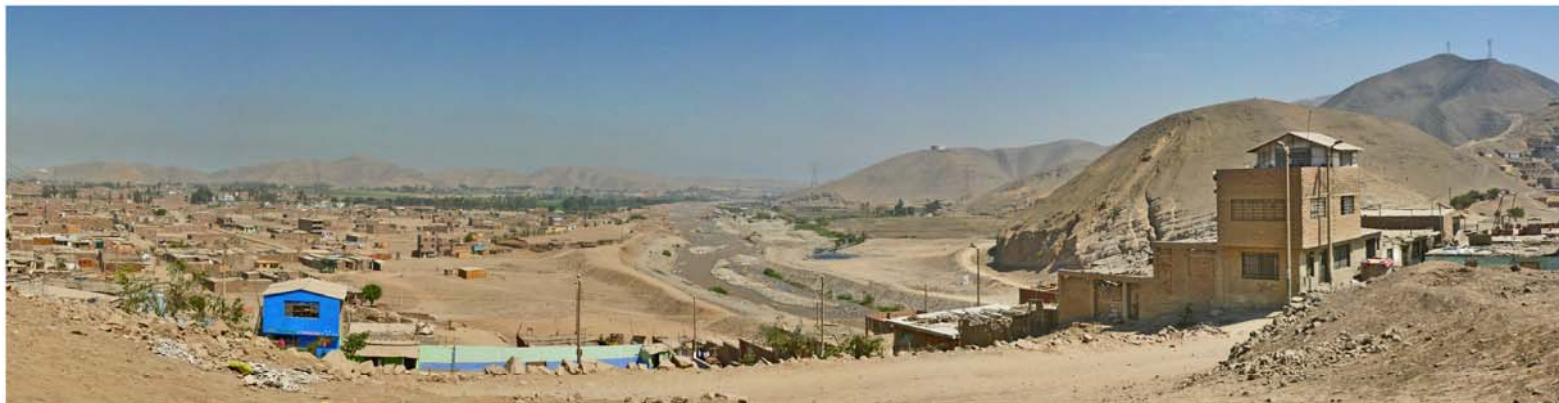
Vista desde el cerro Santa Cruz hacia la boca de la desembocadura del río Chillón.
