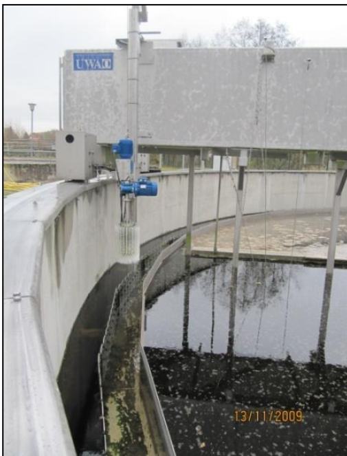
Figura 8: Clarificador del Sistema de Lodos Activados de donde se extrajo la muestra. Eliminación de algas y natas formadas en la superficie del agua (Año 2009).
