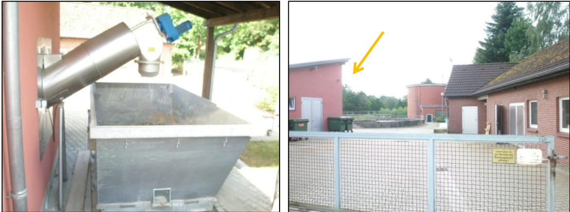
Figura 6: Se muestra a la izquierda la extracción de arena a un contenedor y a la derecha la caseta del sistema de pretratamiento de la PTAR de Suderburgo (Año 2009).
