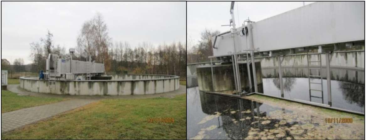
Figura 7: Clarificador Automático del Sistema de Lodos Activados, sistema final de la PTAR de la ciudad de Suderburgo (Año 2009).
