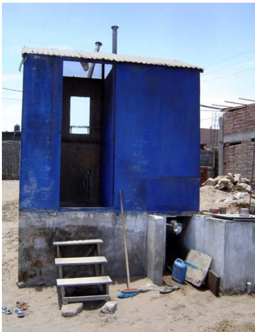
Abb. 5-8: Trockentoilettenmodul in Nueva Pachacutec (Ventanilla)
