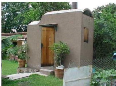
Figura La separación de sanitario seco en México. Fuente: Schlick J. y Werner C. (2001)
