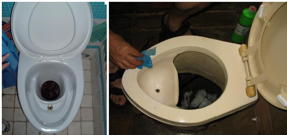
Figura Retrete seco con separador de orina (izquierda) y forma de limpieza del retrete (derecha)
