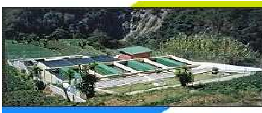
Figura 47 Vista de la planta de tratamiento de aguas residuales de San Antonio en Solalá (Guatemala) que utiliza reactores UASB y filtros percoladores
