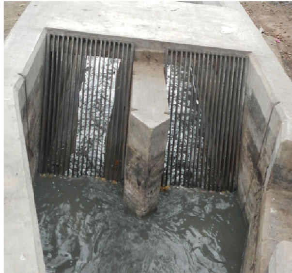
Figura 19 Ejemplo de una cámara de rejas finas.
