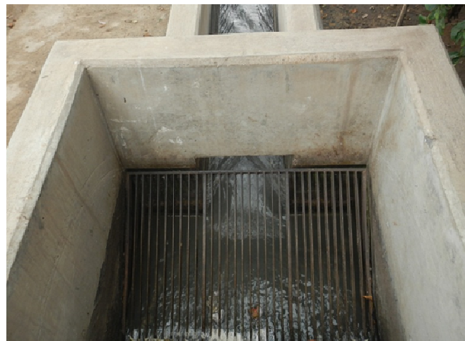
Figura 18 Ejemplo de una cámara de rejas gruesas.
